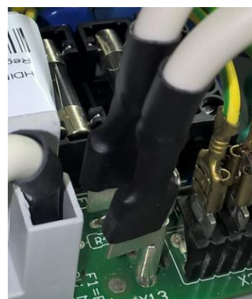
po zapojení kabeláže
